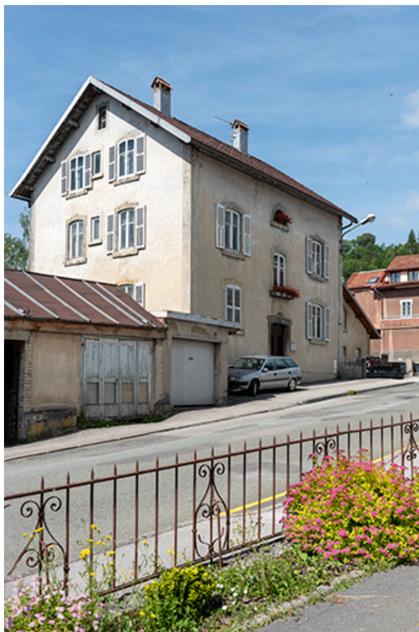
Façades latérale gauche et antérieure.
