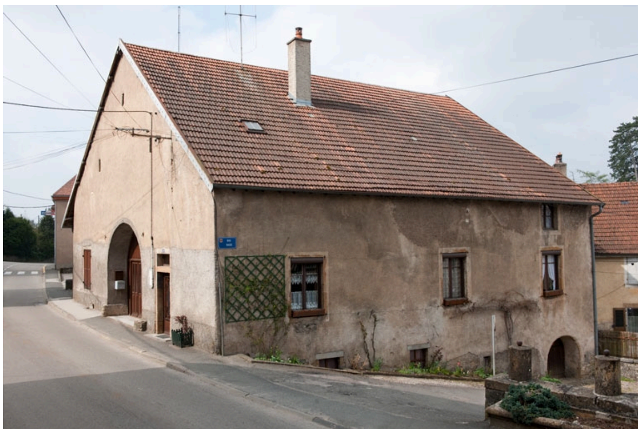
Façade antérieure et façade latérale droite.
