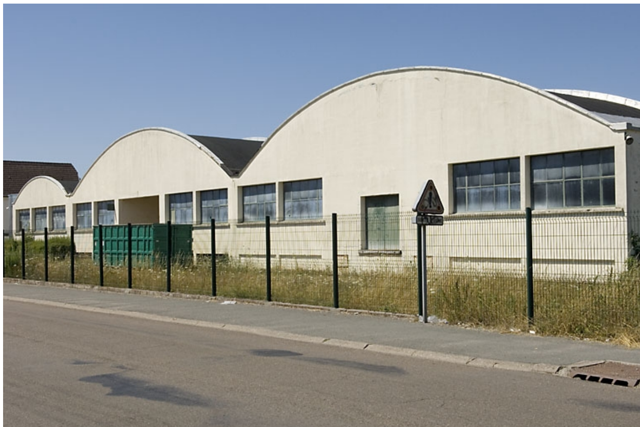
Murs-pignons sur la rue de la Viotte.
