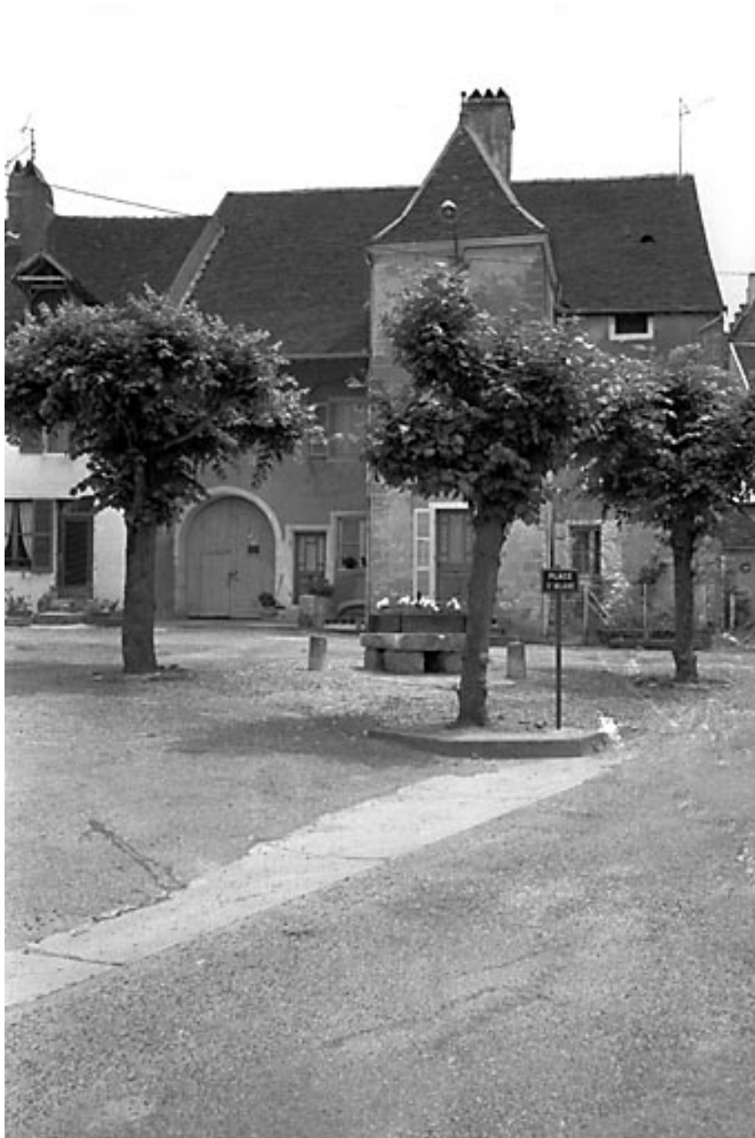
Ferme située rue Saint-Hilaire : façade antérieure vue depuis la place.
