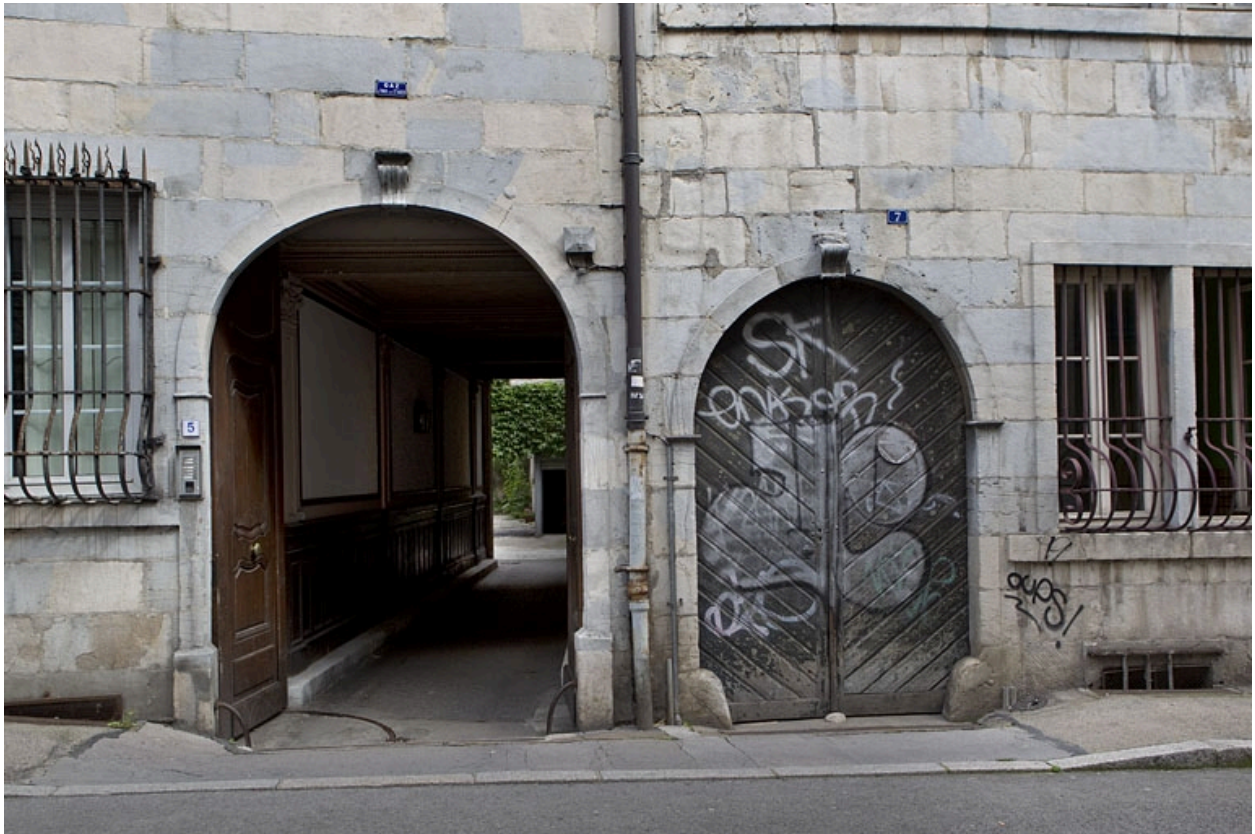
Façade sur rue du logis principal : détail de l'entrée cochère.
