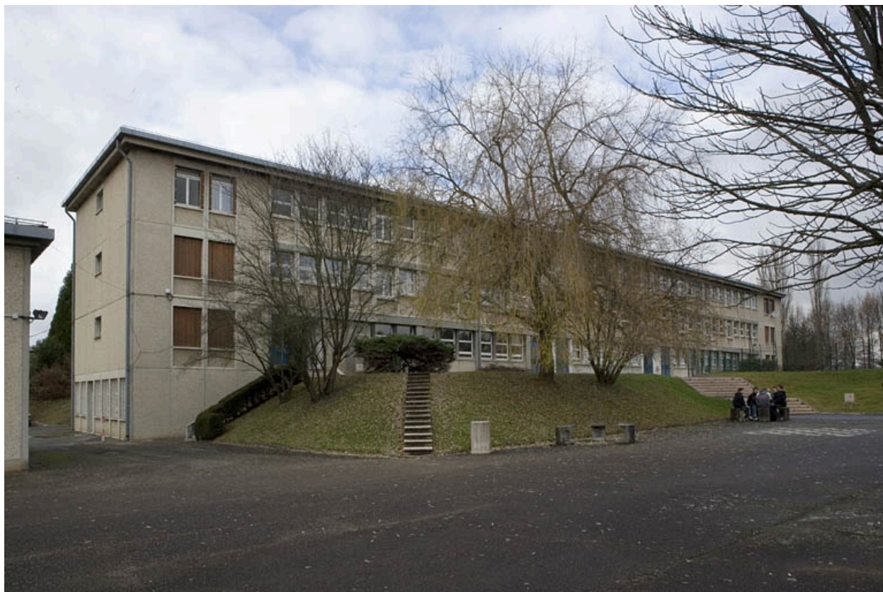
Vue façade antérieure bâtiment C.
