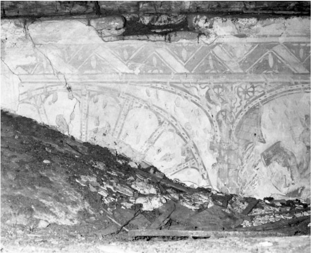
Comble de la nef, mur droit, 4e-5e travées
