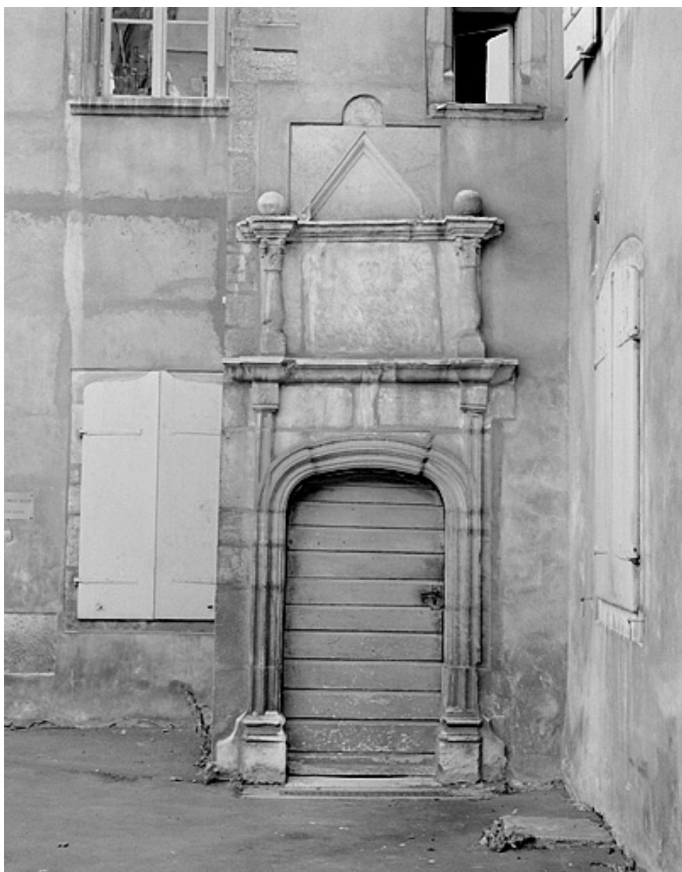
Porte de la tour d'escalier.
