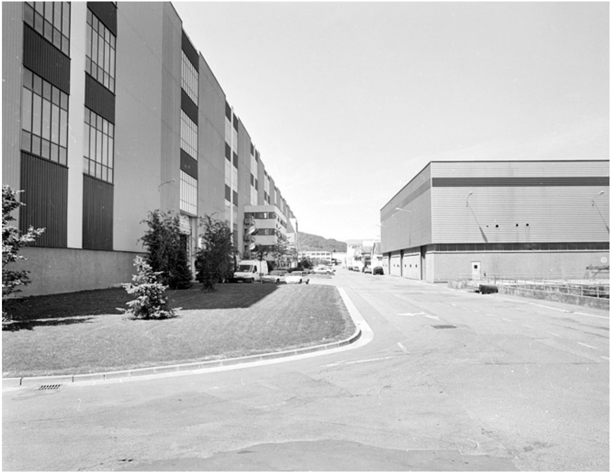
Façade est de la halle 330 (bureaux et ateliers de montage).
