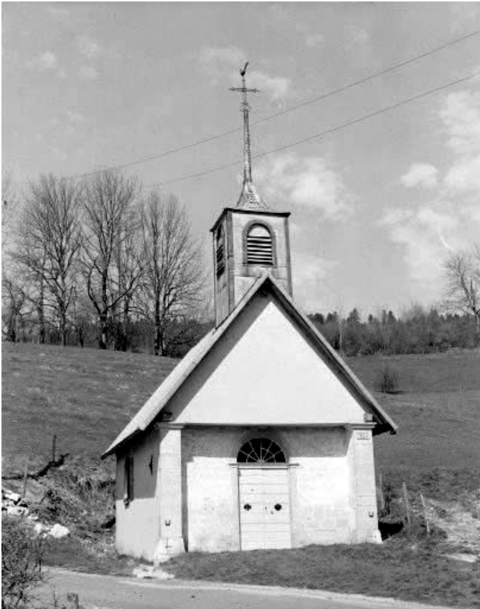
Face antérieure et face latérale droite.
