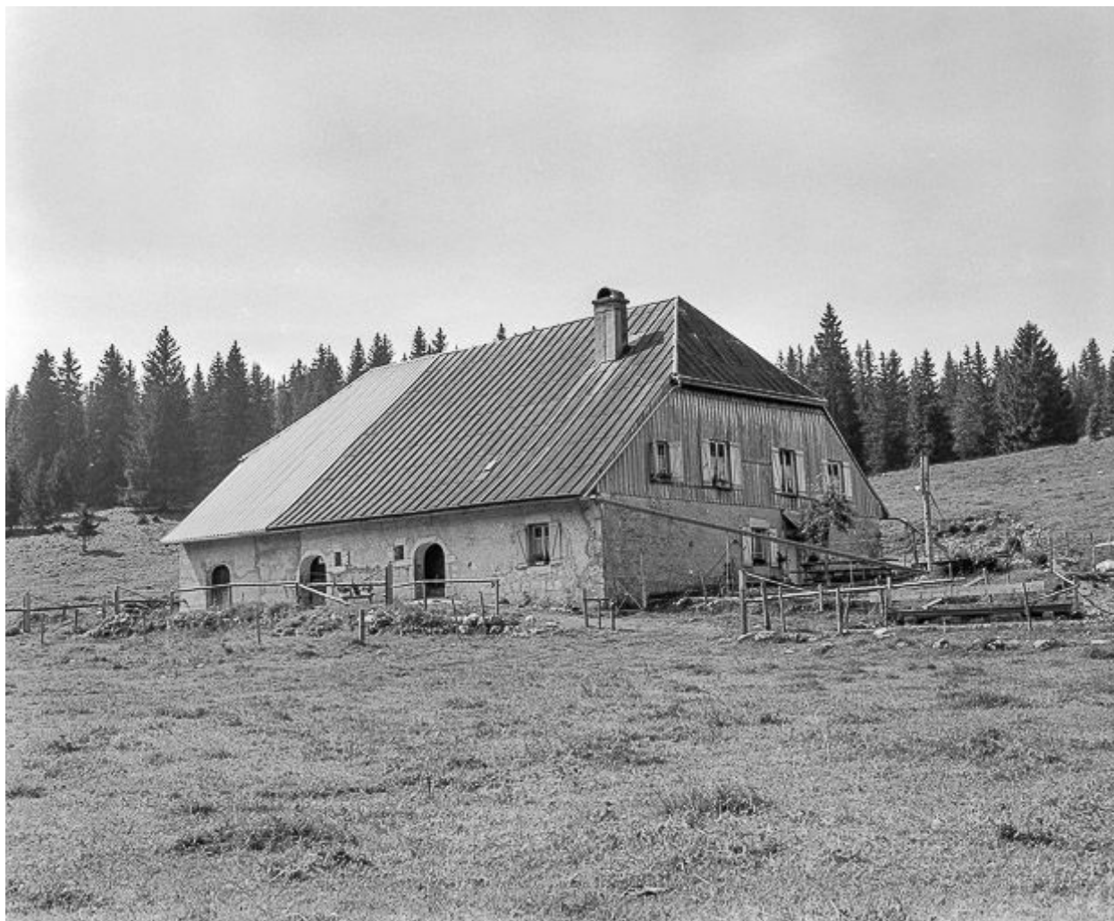
Façade antérieure et latérale gauche.
