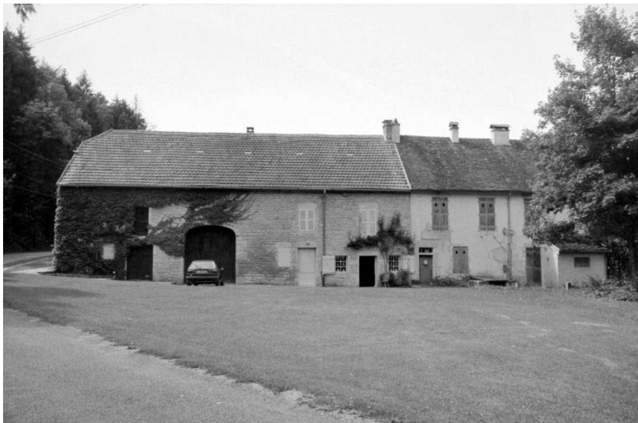
Façade postérieure du logement et de l'étable.
