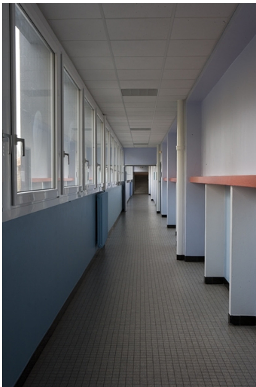
Bâtiment C. Vue couloir.
