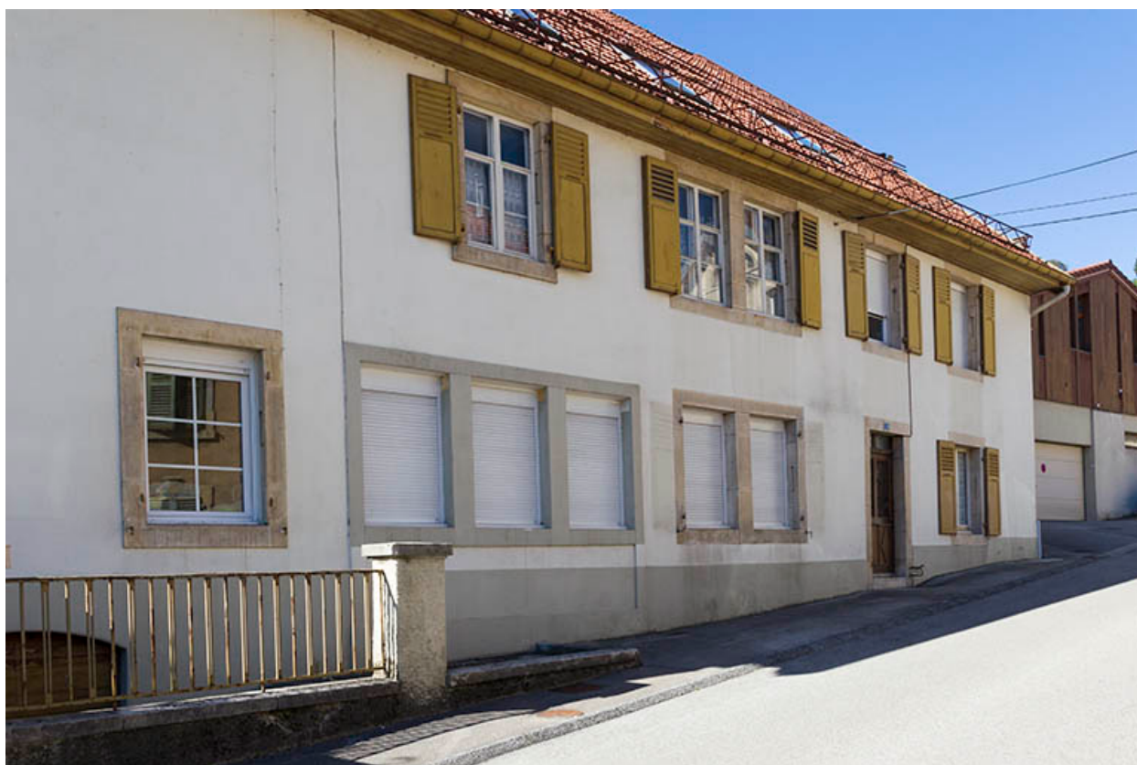
Ferme : façade antérieure, de trois quarts gauche.
