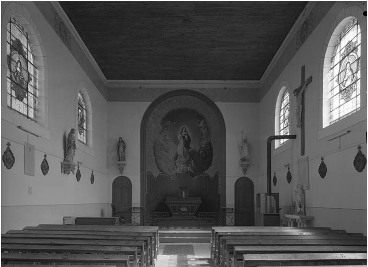
Vue intérieure vers le chœur. Peinture monumentale.
