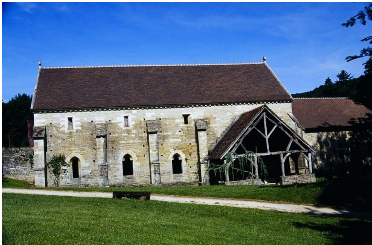
Le cellier, élévation est.
