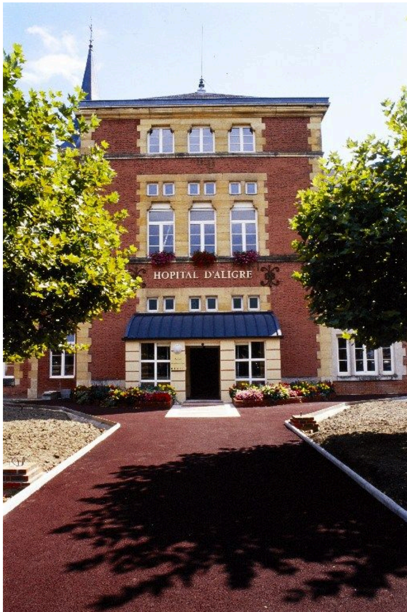
Façade postérieure de l'aile droite : entrée de l'hôpital.
