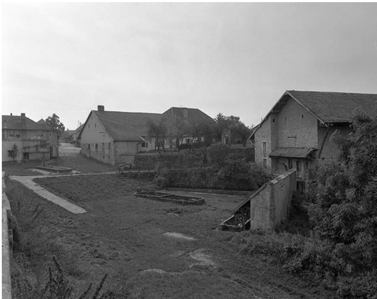
Fontaine et lavoir situés rue de la Perrière.
