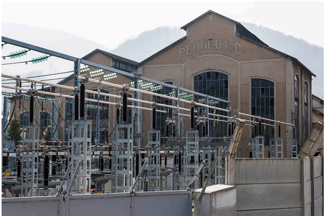
La centrale thermique.
