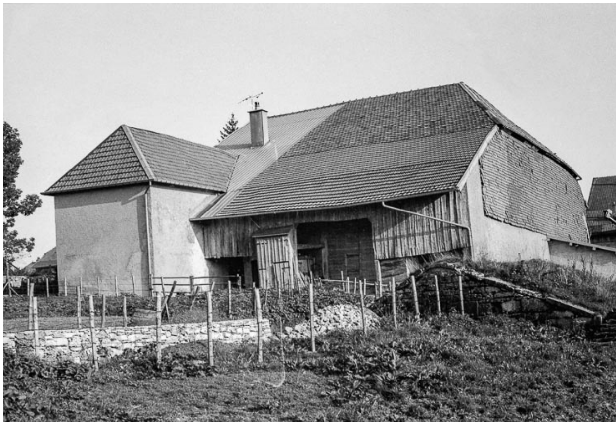
Ferme : façade postérieure.
