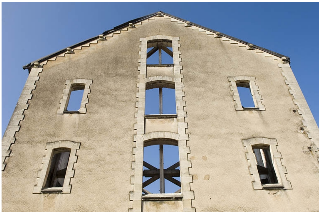
Aile ouest. Pignon sur rue.
