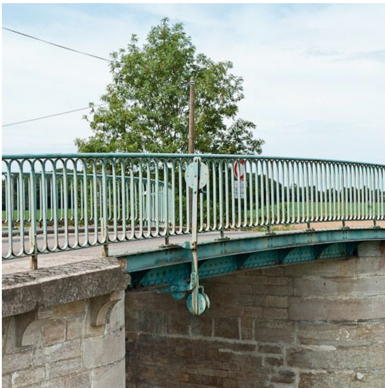
Détail du garde-corps avec la poulie.
