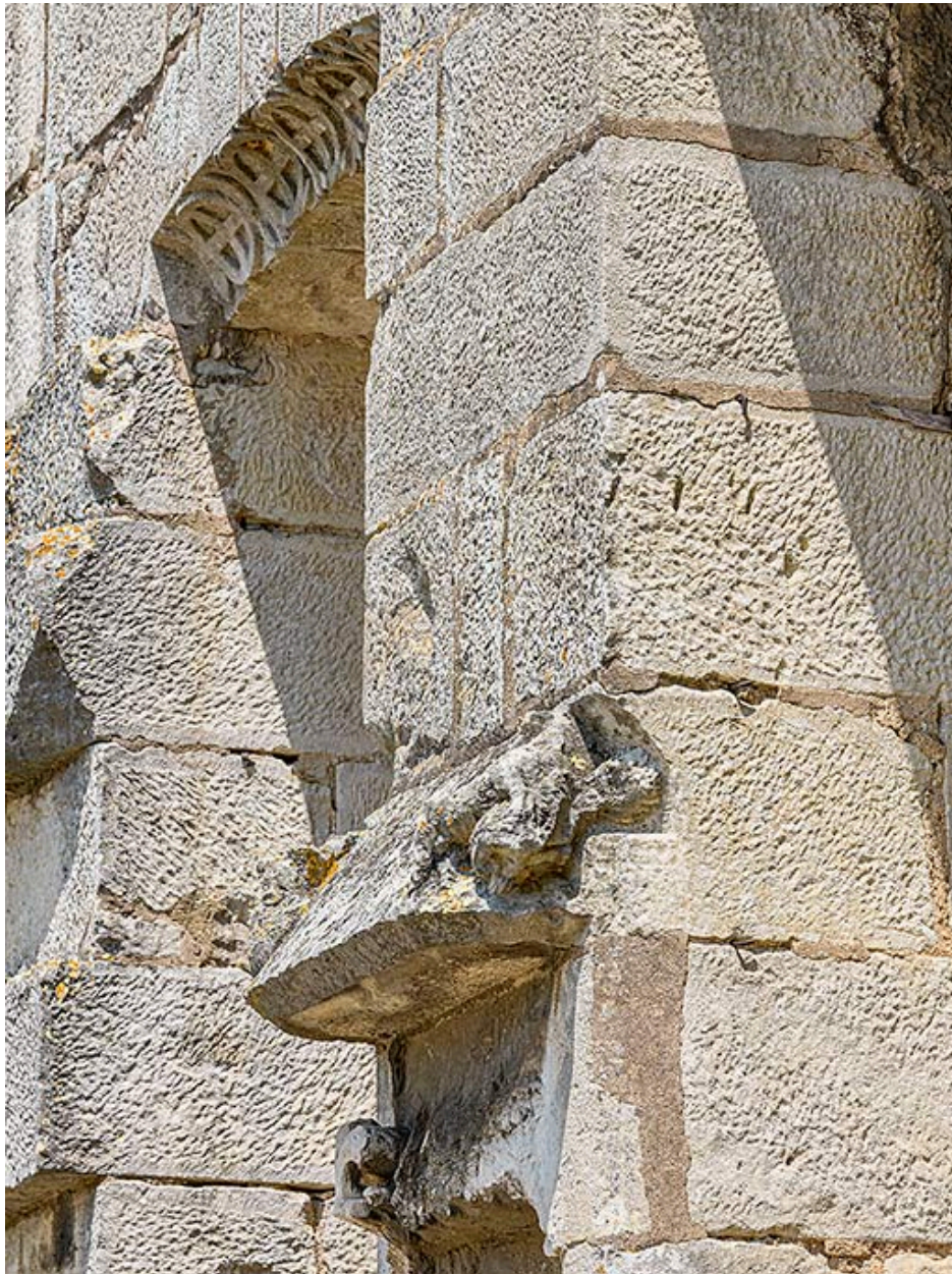
Détail sur la maçonnerie en pierre de taille.
