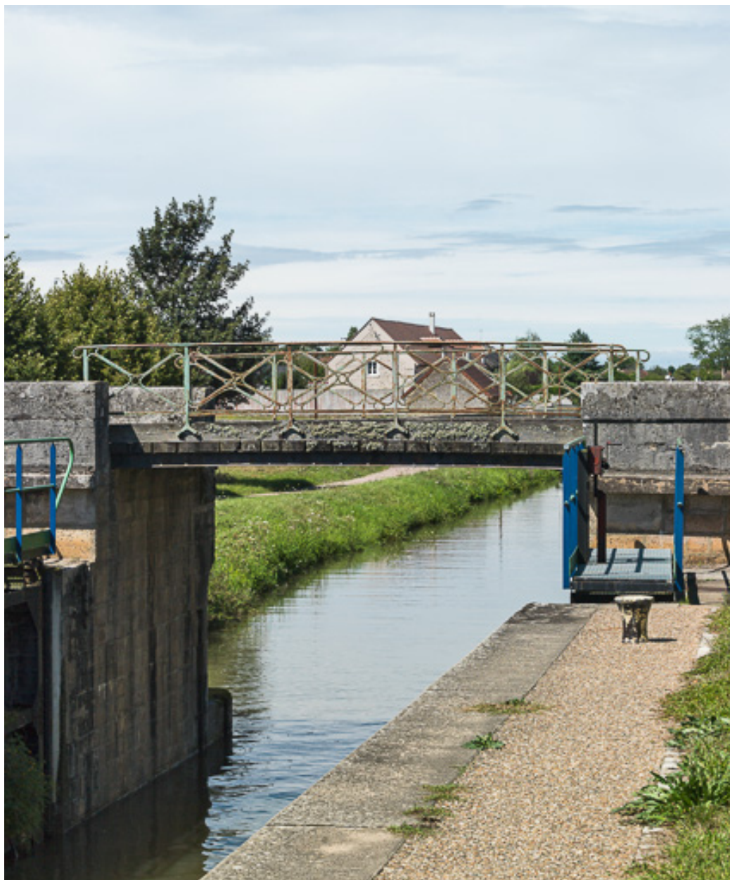
Vue du pont.
