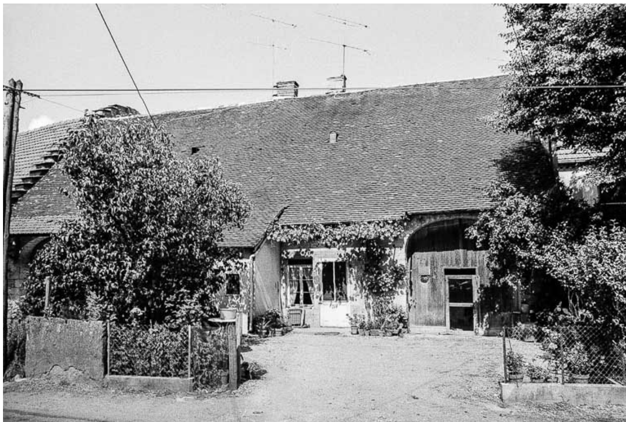
Ferme située 135 rue Général Gauthier : façade antérieure.
