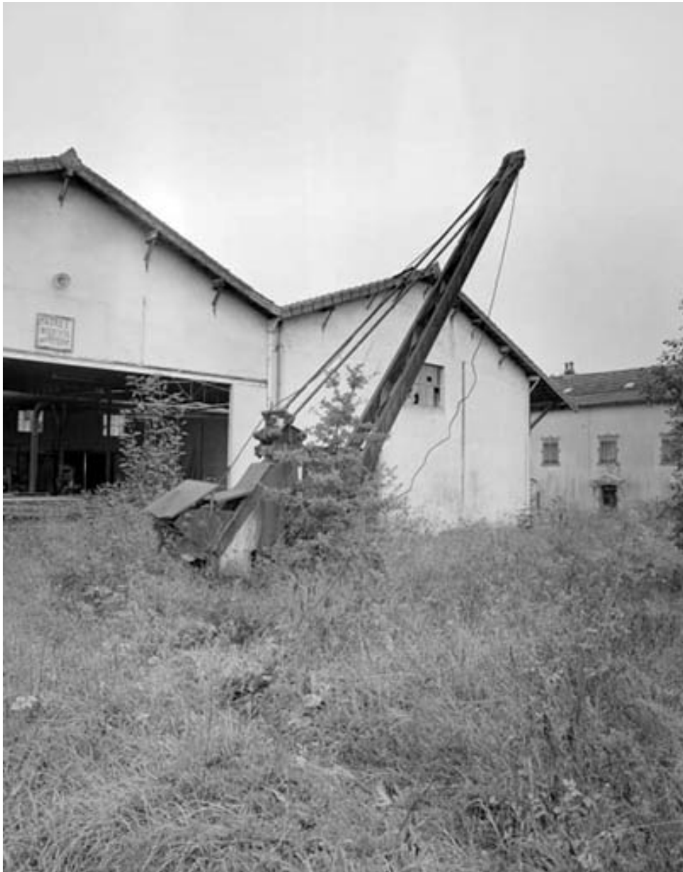
Grue sur l'aire des matières premières.
