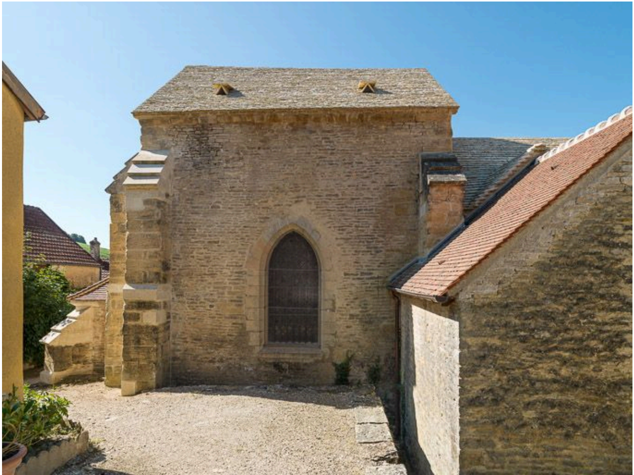
Elévation nord-est du choeur.
