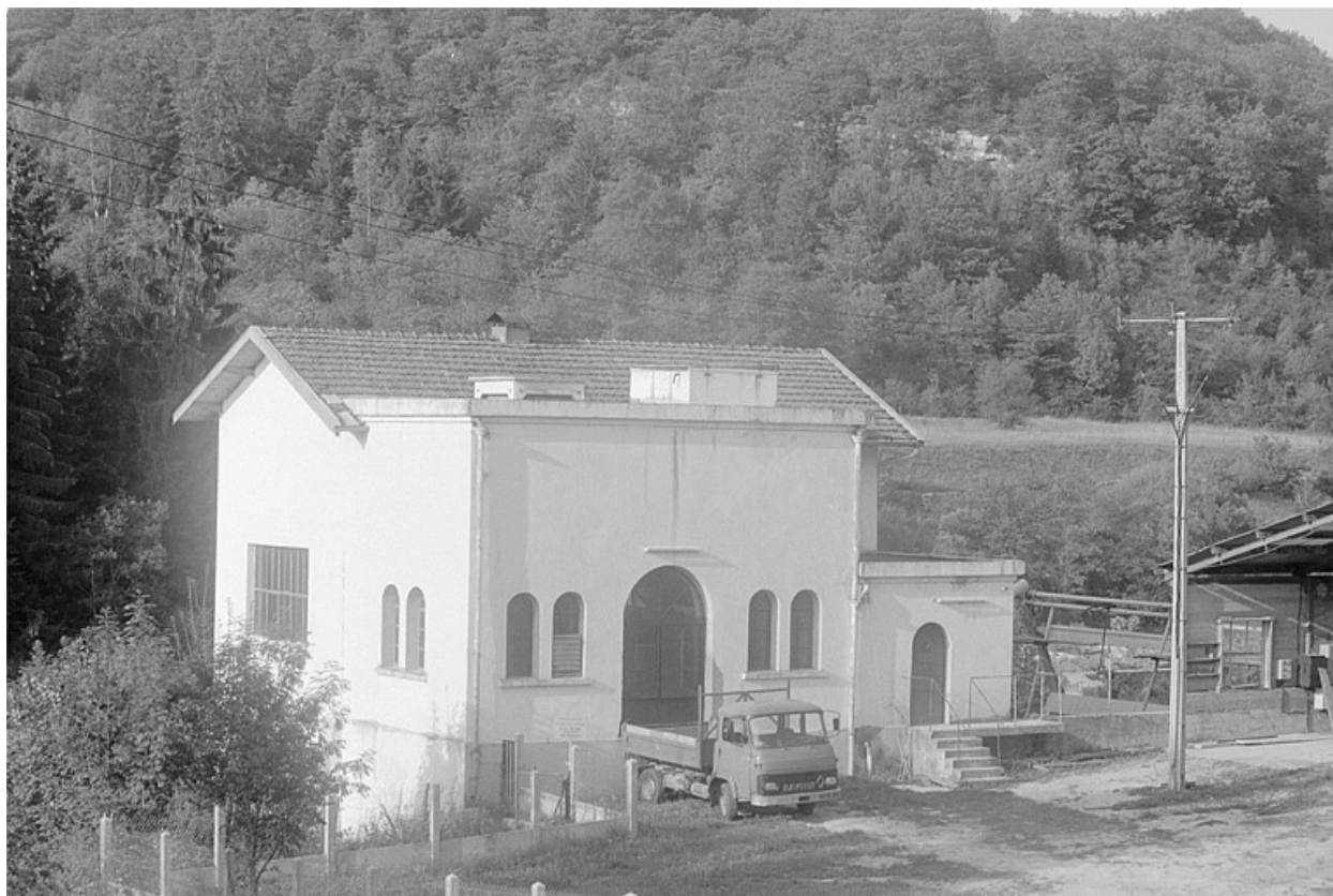
Façades antérieure et latérale gauche.
