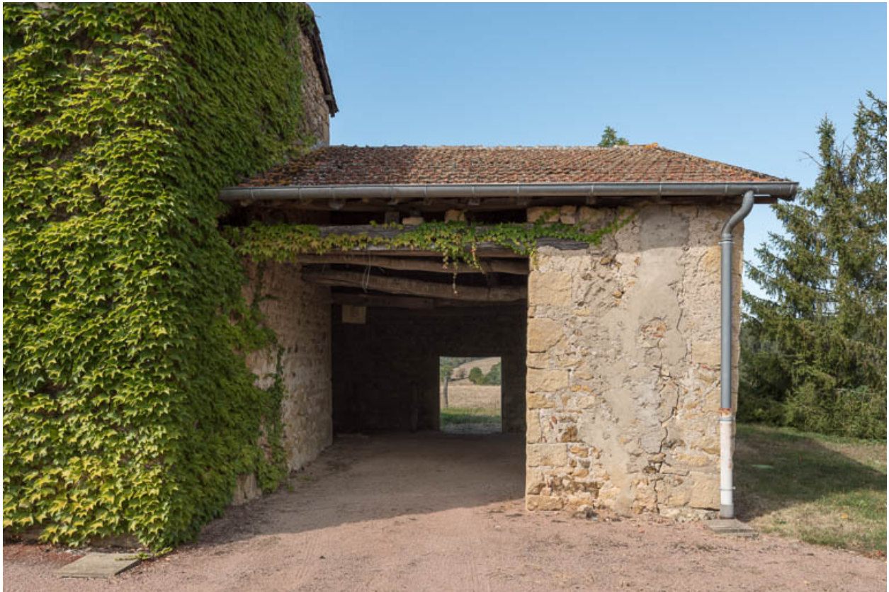
Vue du hangar agricole, construit contre le mur-pignon est de l'ancienne maison
