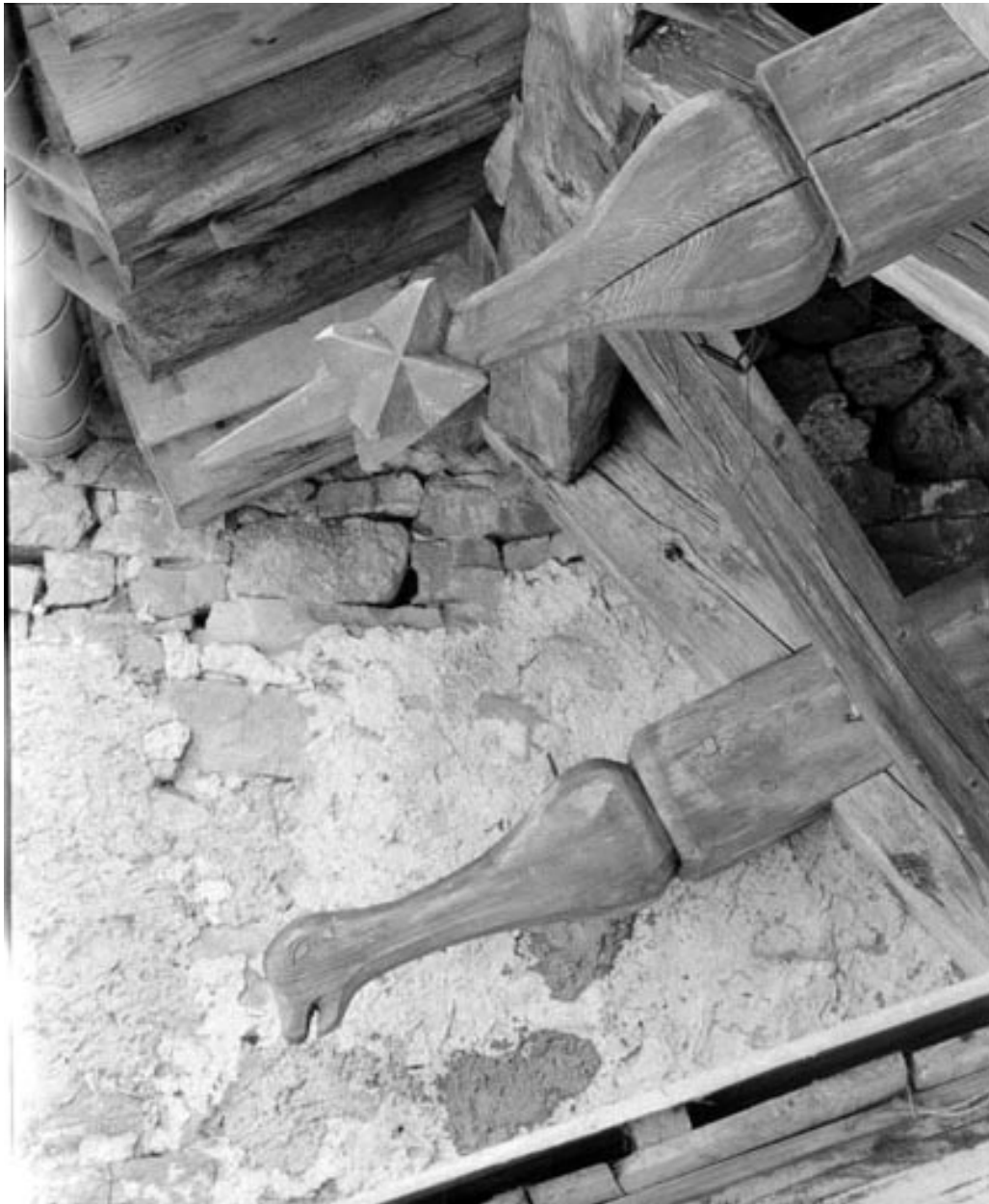
Détail : extrémité d'arbalétriers sculptés.
