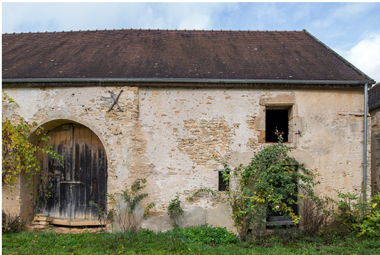
L'extrémité orientale de la ferme, depuis la cour.
