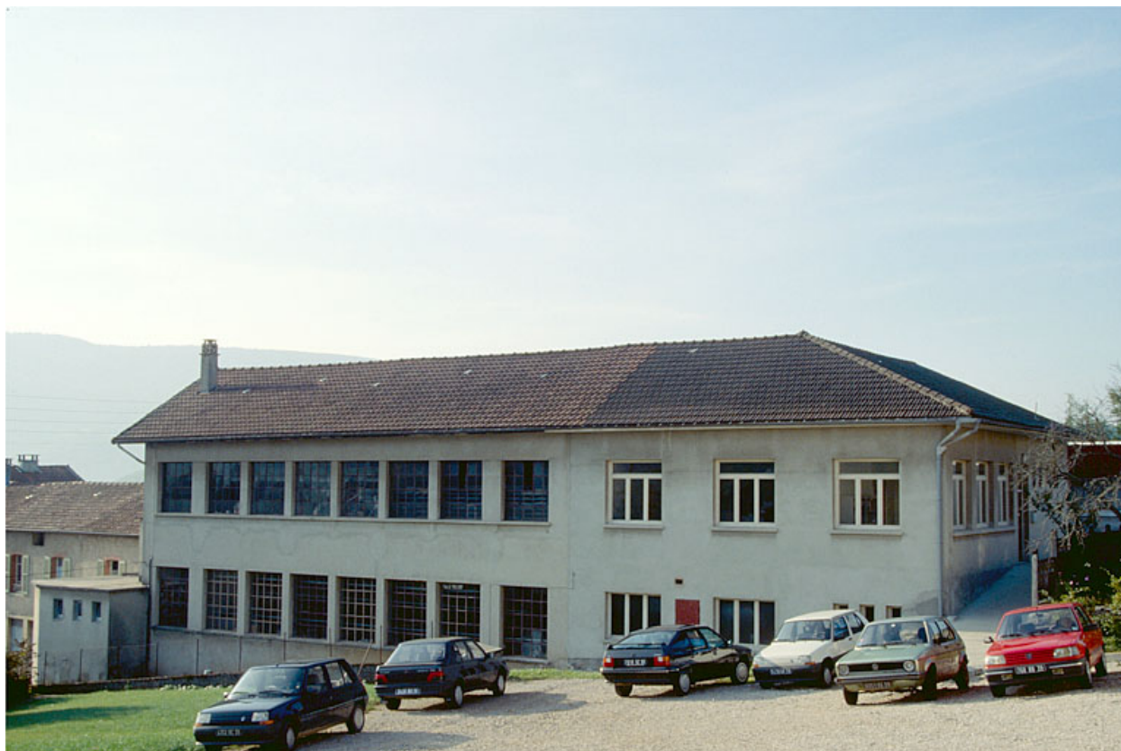
Atelier de fabrication (H), vu du nord-ouest.
