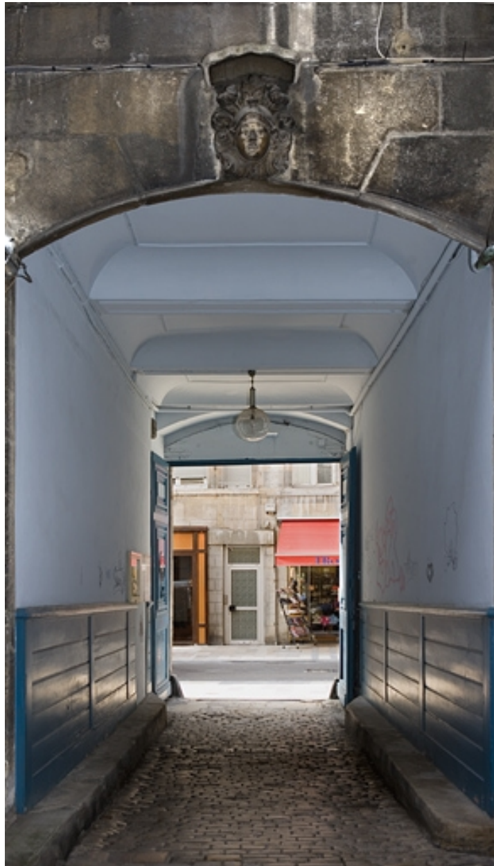
Vue du passage cocher depuis la première cour.
