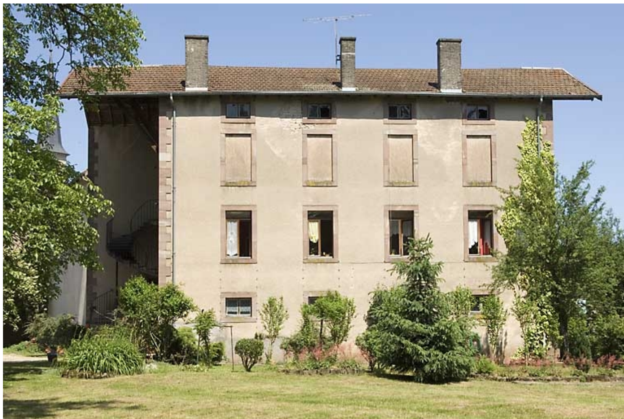
Atelier de distillation et chai (?). Façade sud-ouest.
