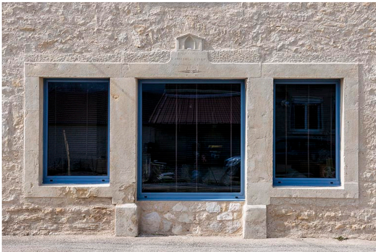
Ouvertures du mur-pignon est.
