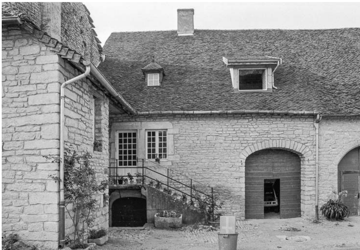
Ferme cadastrée AD 322 : façade antérieure.
