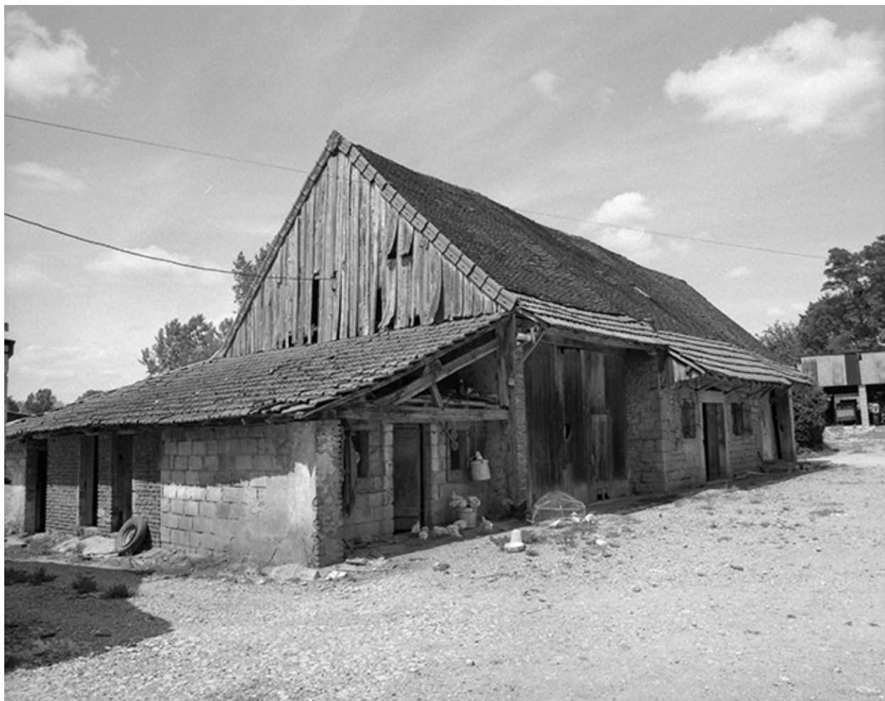
Partie agricole d'une ferme.
