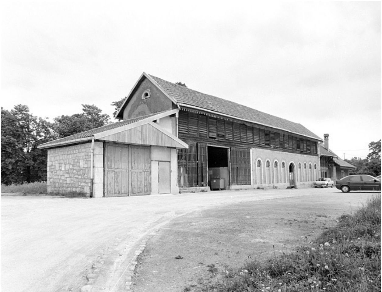
Vue de trois quarts de l'orangerie.
