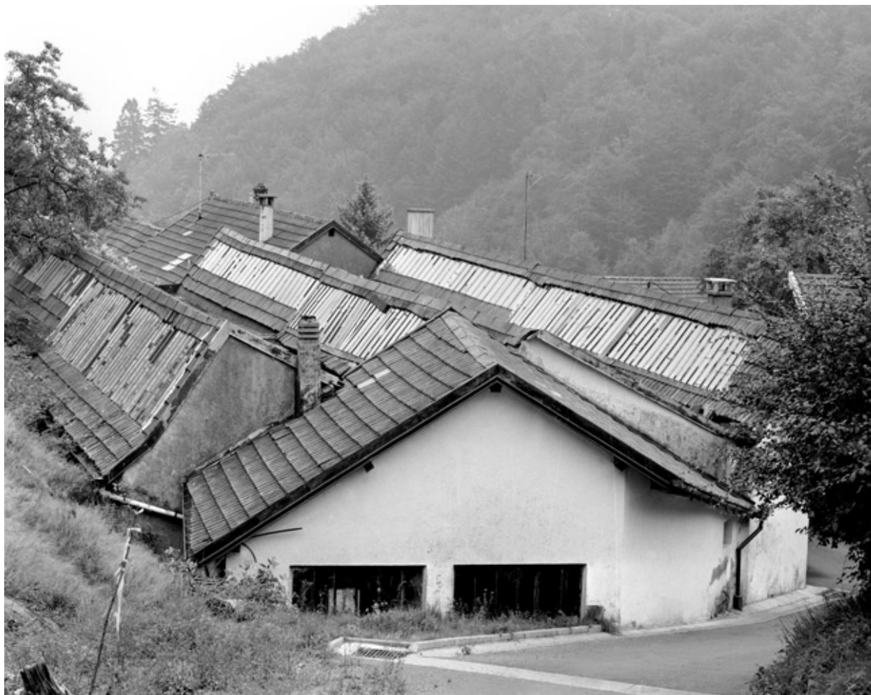
Sheds de l'atelier de fabrication depuis l'ouest.
