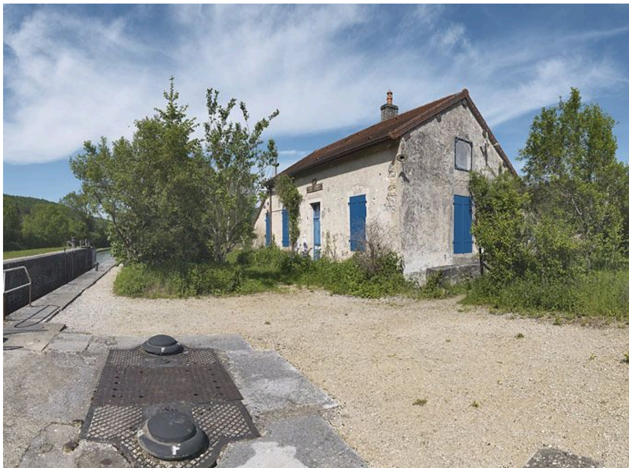
Maison éclusière de 3/4.
