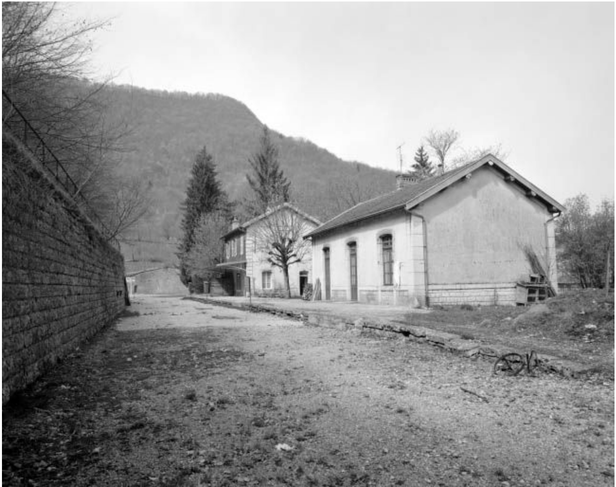
Lods, vue générale des bâtiments de la gare depuis la voie ferrée.
