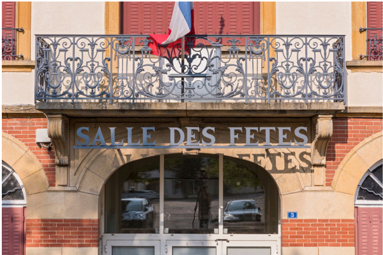
Façade antérieure : enseigne et balcon.
