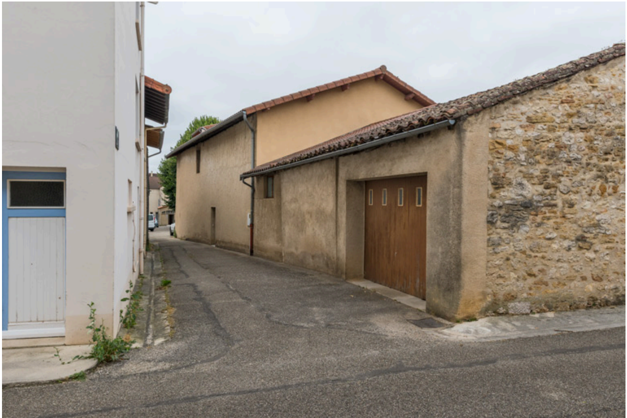
Façades postérieure et latérale droite.
