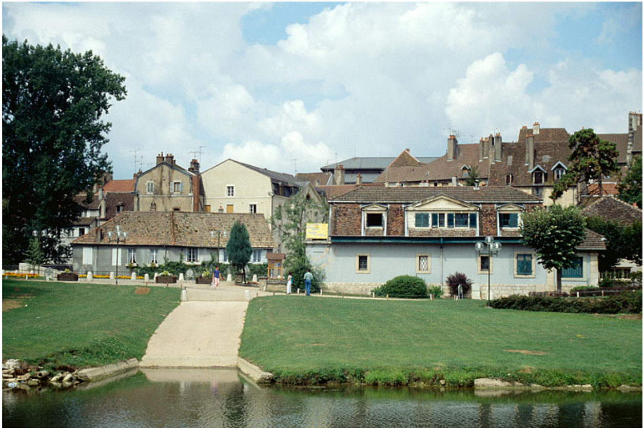
Bureau et logement d'ouvriers (H), depuis l'est.
