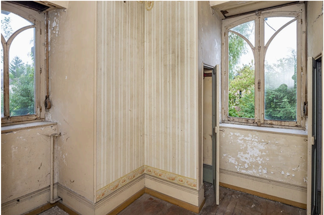
Placard de la chambre sud-est du premier étage.
