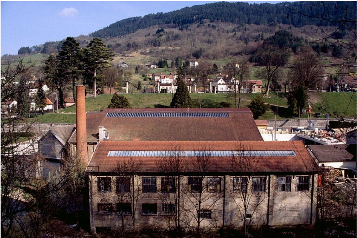
Façade postérieure de l'atelier de mécanique générale.
