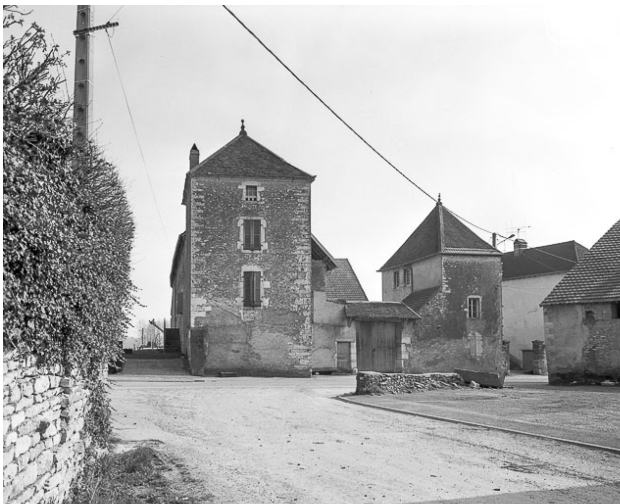
Vue d'ensemble depuis la rue d'Avrigny.
