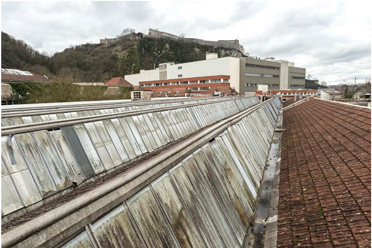
Etat en 2016. Usine A : sheds de l'atelier de réparation, vus de la chaufferie.
