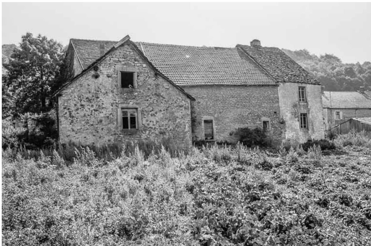
Ferme cadastrée ZK 40 : façade postérieure.
