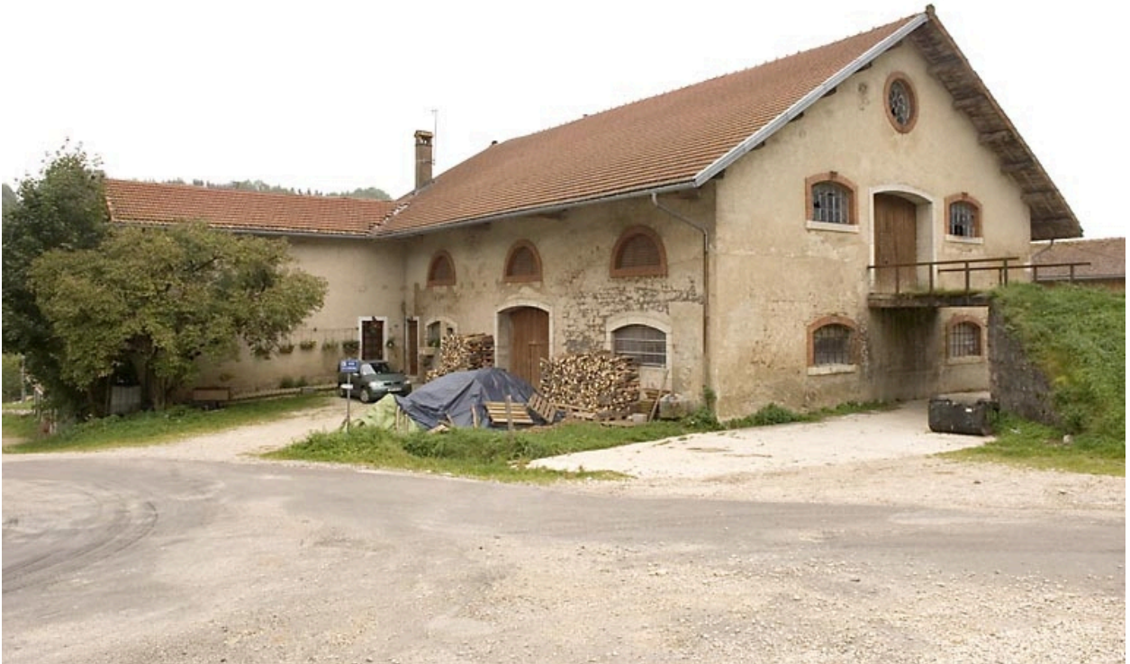
Etables et granges : façades postérieure et latérale droite.
